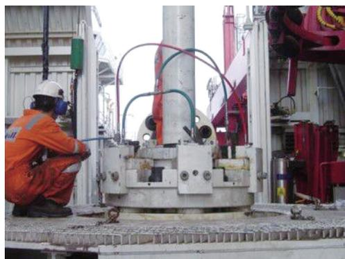
图 1 隔水管下放试压现场作业图
